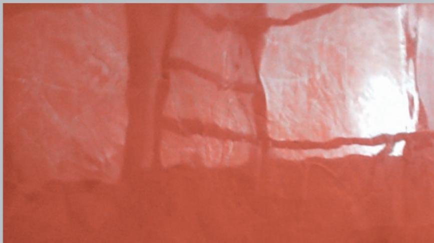
Während des Materialauftrags entwickelt sich der Glanz immer stärker und kann nach Beendigung des Materialauftrags durch weiteres Polieren bis zu spiegelnden Höhen entwickelt werden (siehe Technische Information Nr. 561).
